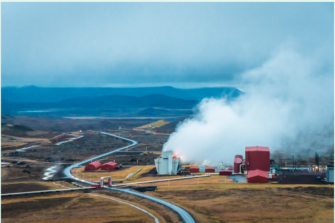
Вулкан Крафла в Ісландії. Геотермальна електростанція Kraflutóed використовує гарячу пару для виробництва електроенергії
