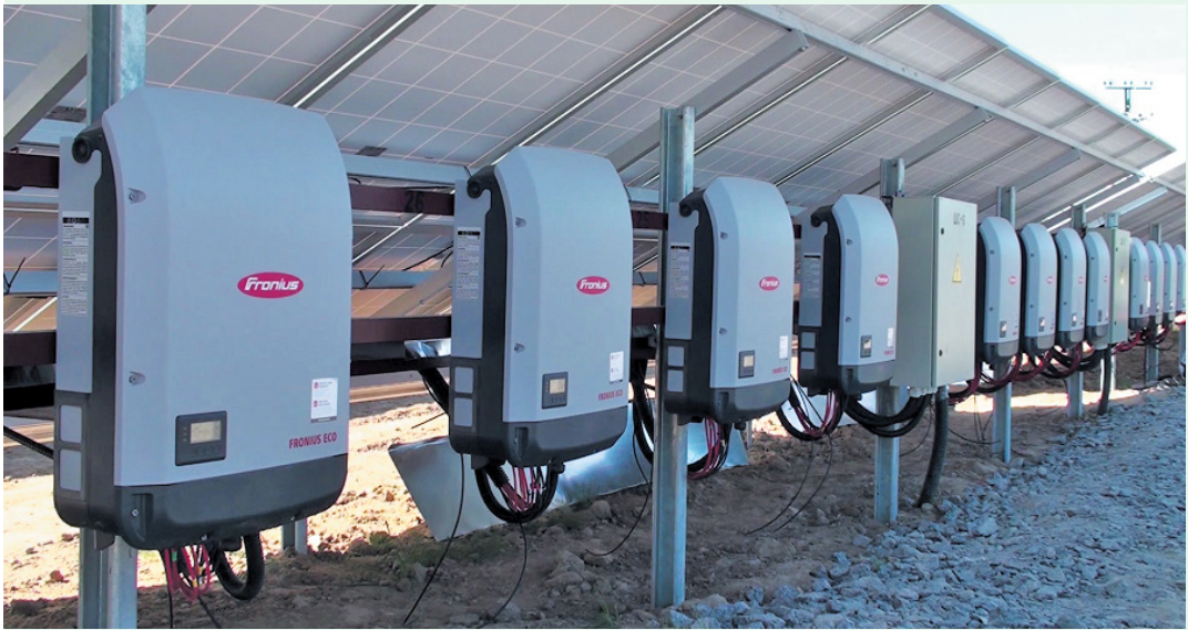
Фото 9. Система інверторів, встановлених на СЕС у Калинівському районі Вінницької області. https://bit.ly/3ubF5MP
