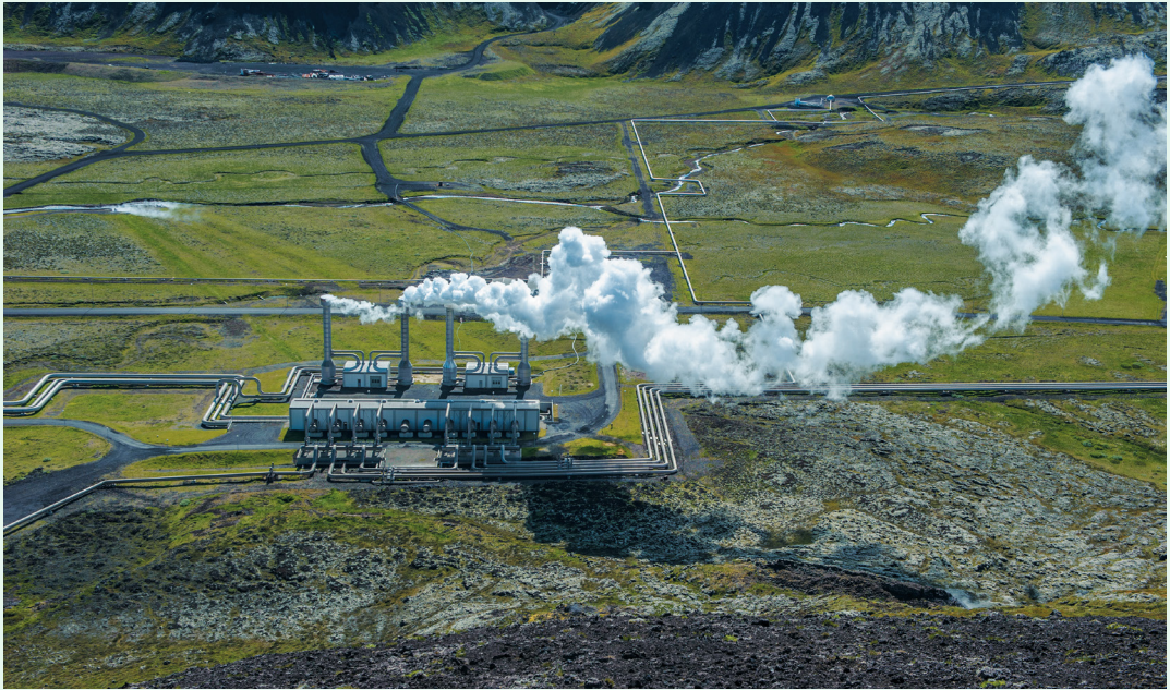
Фото 19. ГеоТЕС Несьяведлир (Nesjavellir) в Ісландії. Електрична потужність – 120 МВт
