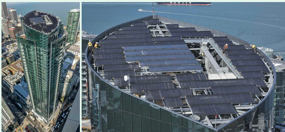
Фото 1. Вежа Rincon Hill у Сан-Франциско, на даху якої монтують колектори для отримання 19 т гарячої води. https://bit.ly/3meqJbN
