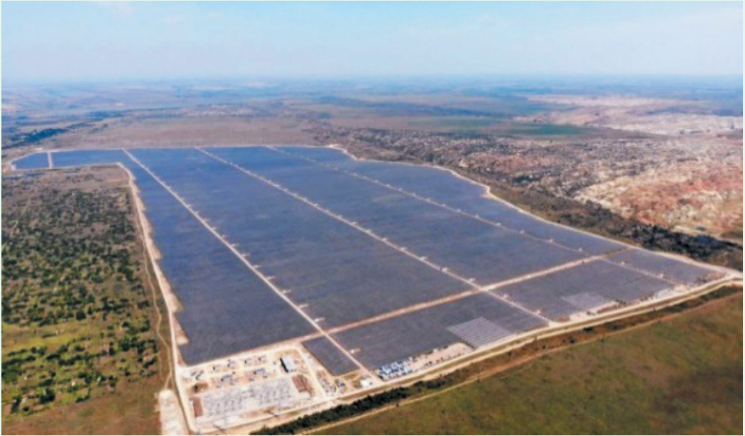
Фото 25. Геліополе Покровської СЕС площею 43 га, яке складається з 840 тис. панелей одиначною потужністю 370 Вт
