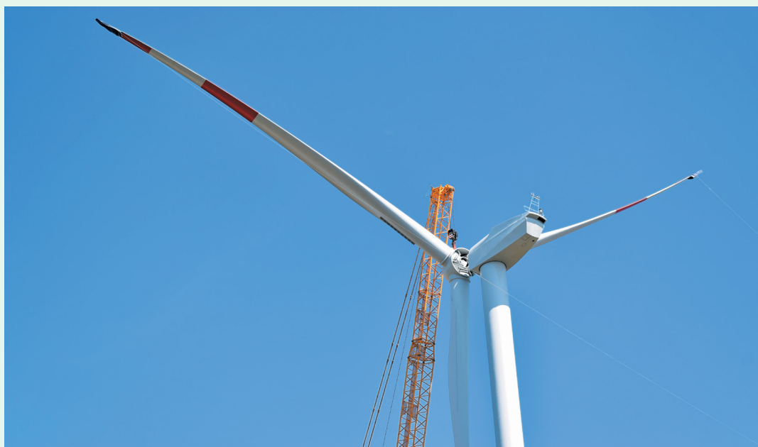
Фото 26. Монтаж лопаті вітрогенератора
