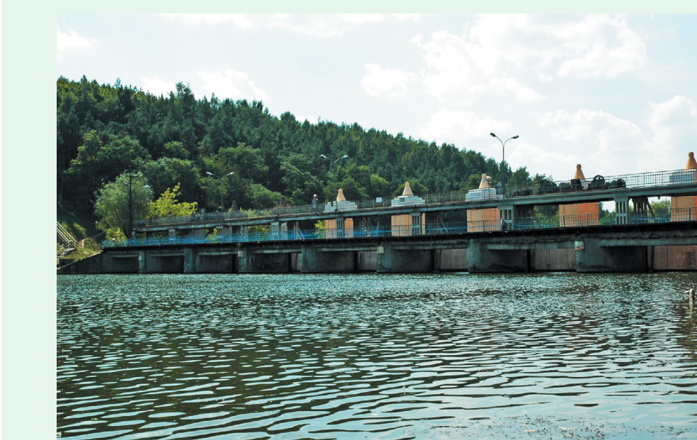
Фото 17. Мала ГЕС у передмісті Вінниці (селище Сабарів). Дата побудови – 1924 р. Потужність – 1050 кВт. Обладнана 8 шлюзами. Зараз експлуатується ТОВ «Енергоінвест». Отримує «зелений» тариф за вироблену е/е.
